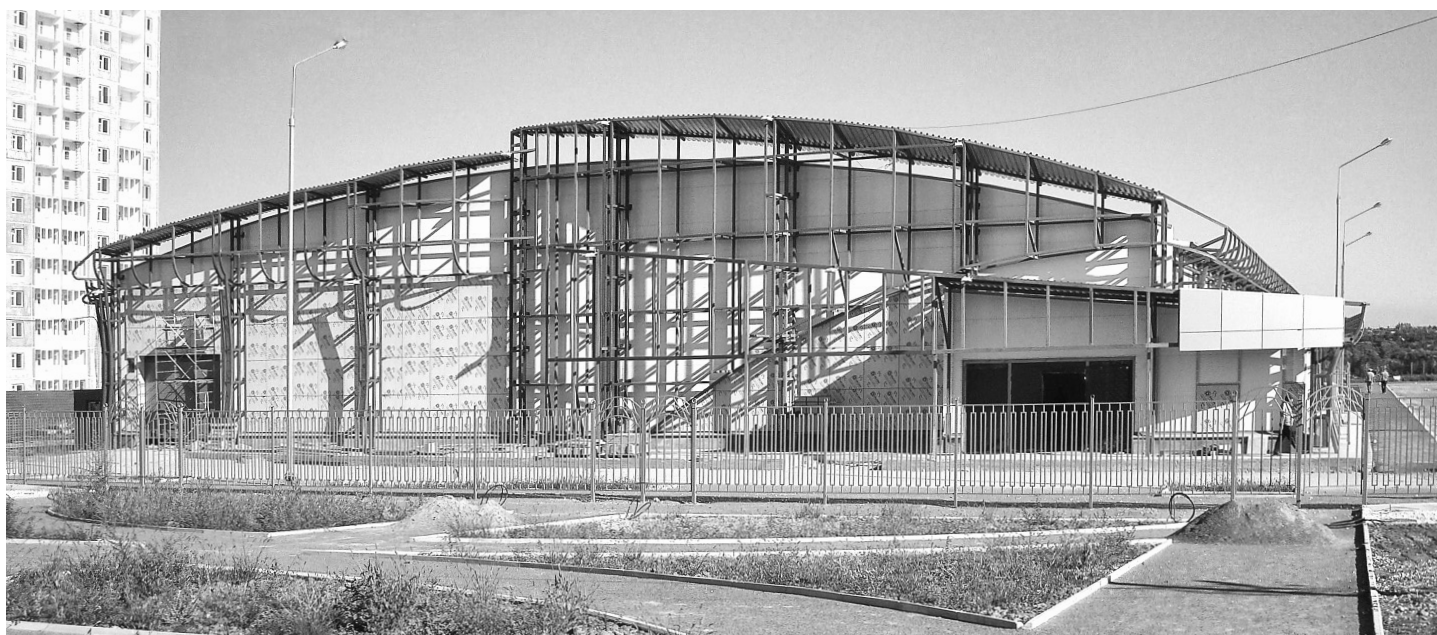
Строительство «Ледовой арены» идёт по графику
