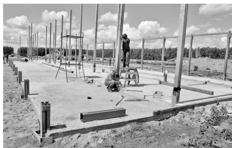
Ведется строительство второй очереди молочного комплекса.
