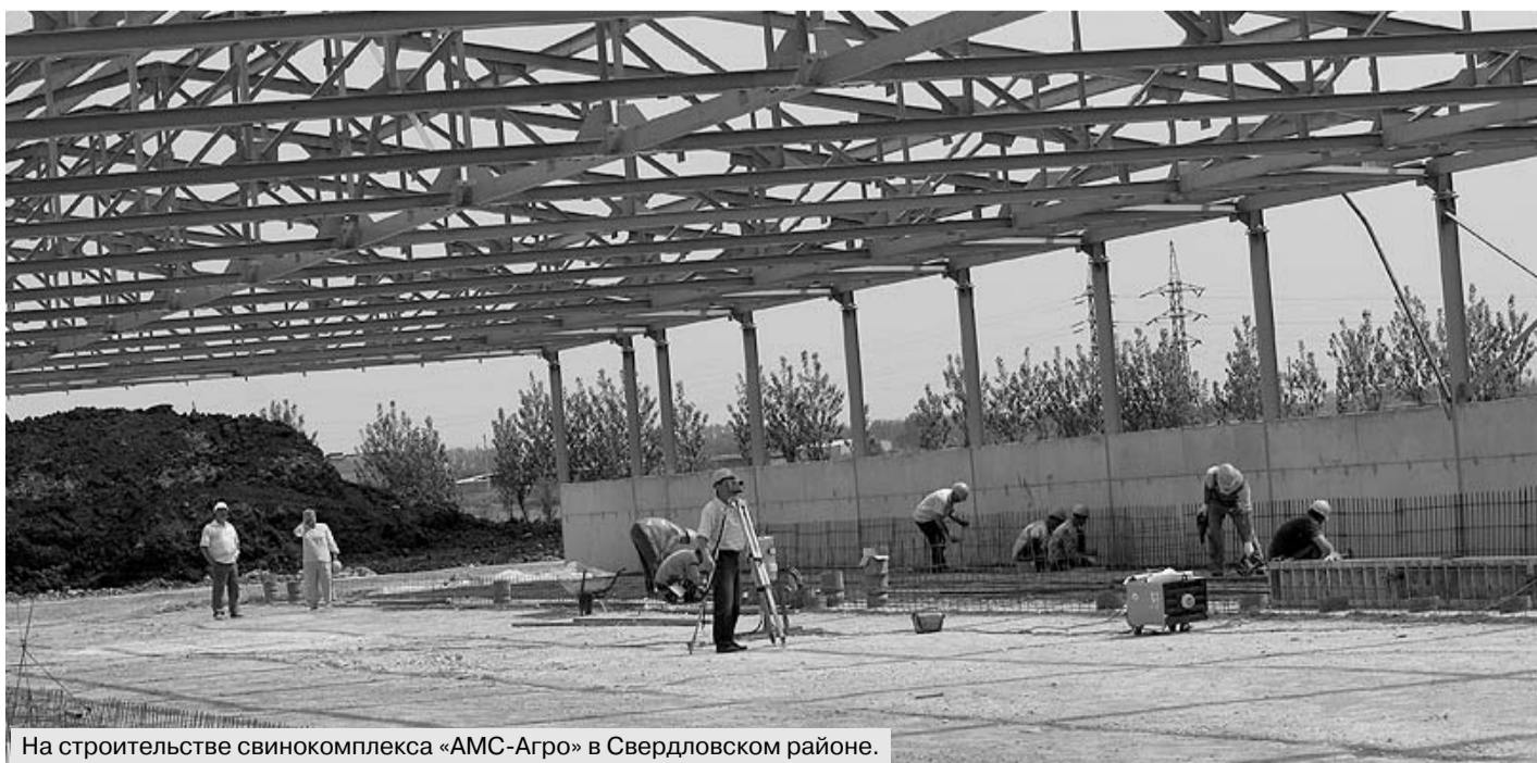
На строительстве свиноконцентра «АМС-Агро» в Свердловском районе.
