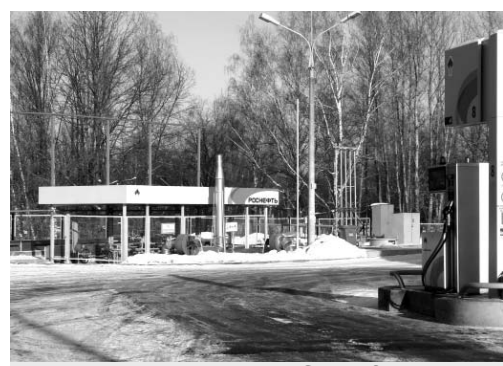
Газовый пост АЗК № 3.
