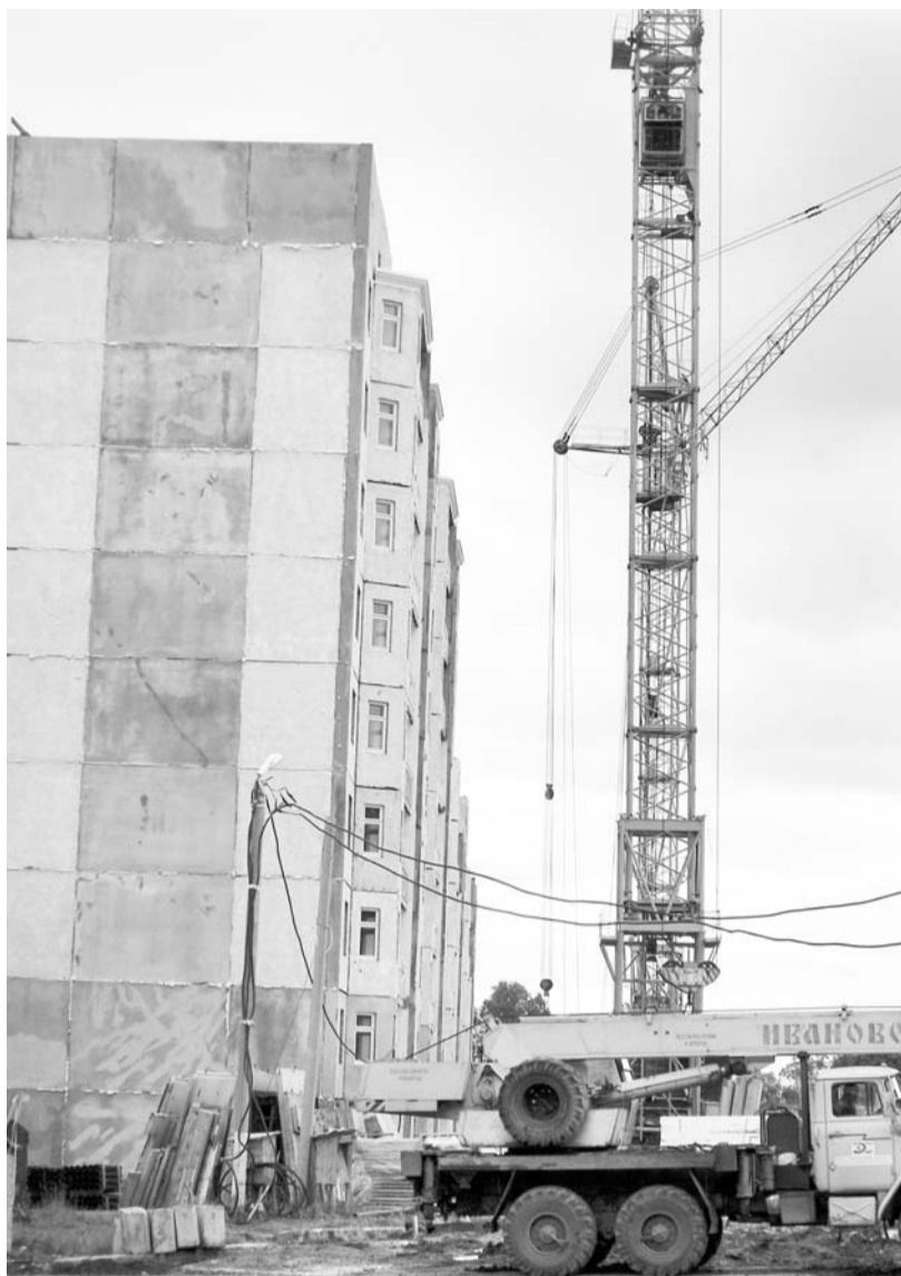
Крыша дома № 16 едва не стала местом гибели для строителей
