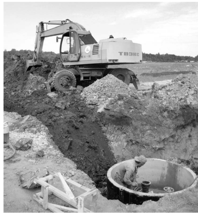
Строительство водопровода в коттеджном поселке вблизи Малой Куликовки.
