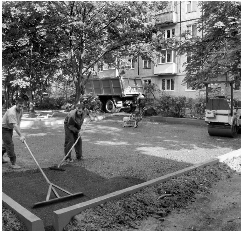
На благоустройство дворов и межквартирных проездов нашей области дают 156 млн. рублей
