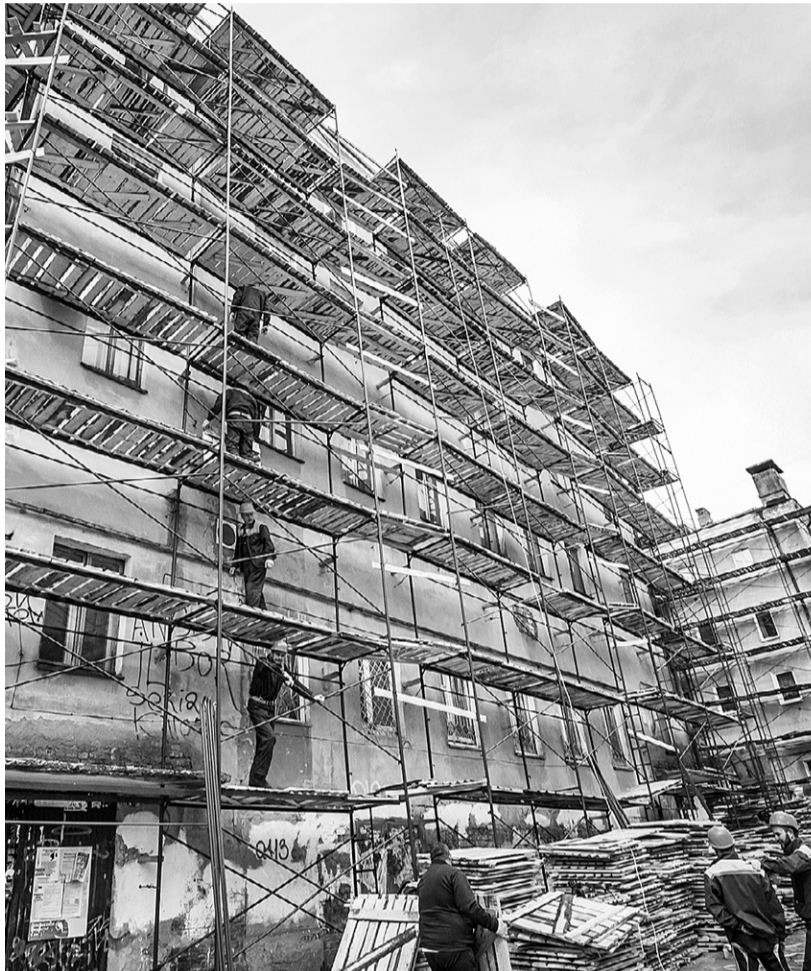
За проведением капремонта нужен глаз да глаз
