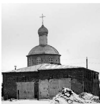
хранящихся в Санкт-Петербурге. Предстоит еще немалый объем работ: отделка, возведение колокольни. Наталья ЗАРУБИНА. Знаменский район.
