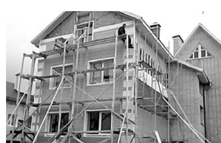
доставление финансовой поддержки за счет средств фонда на проведение капитального ремонта необходимо провести собрания собственников жилья в этих домах.
