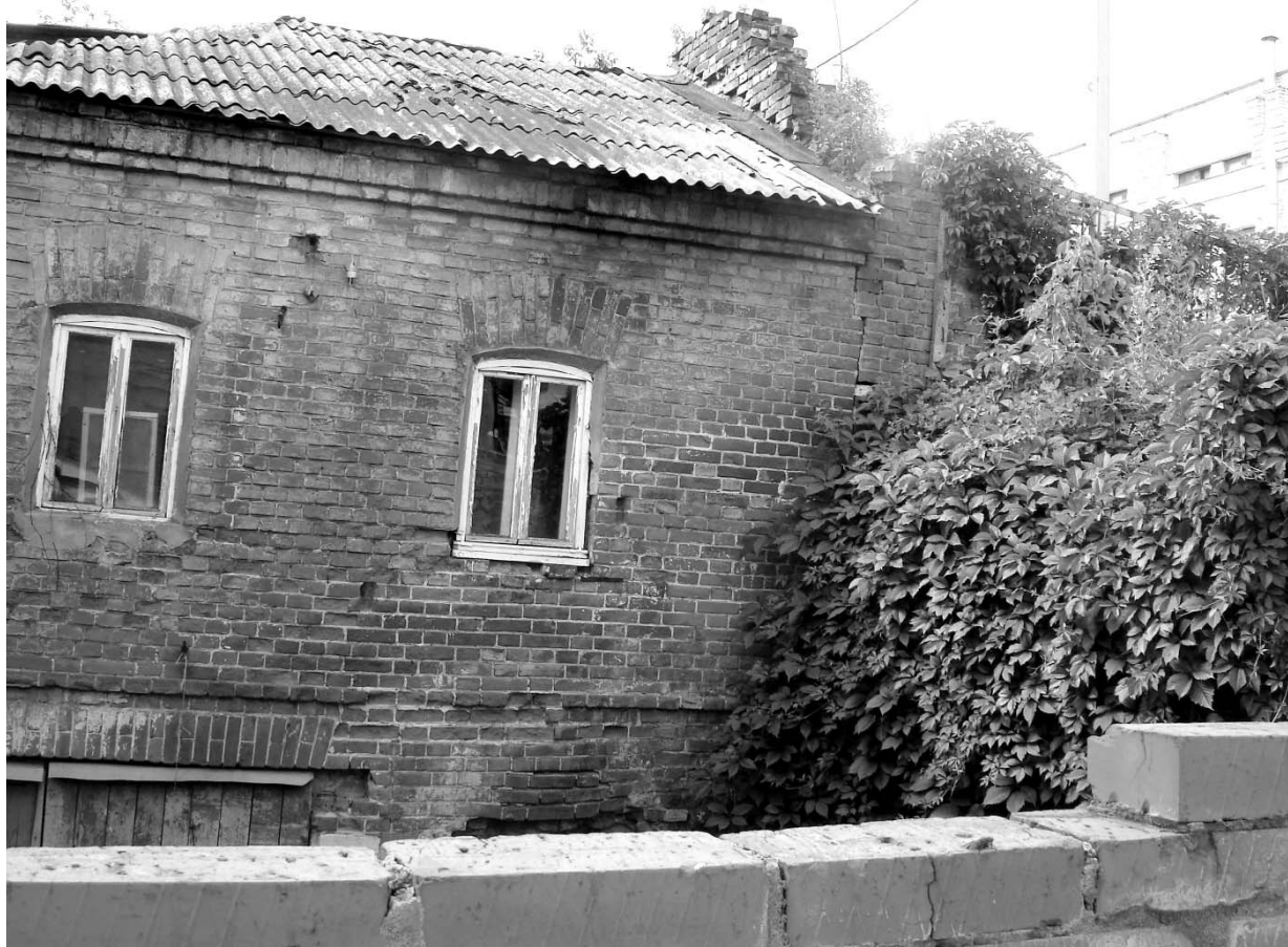
Древняя монастырская постройка (тыльная сторона дома на Ленина, 11)
