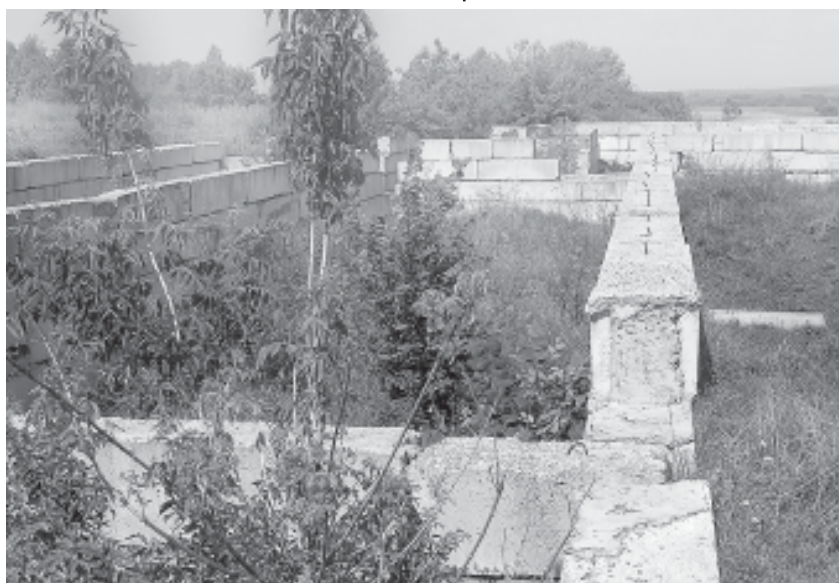
Фундамент под бурьяном.
