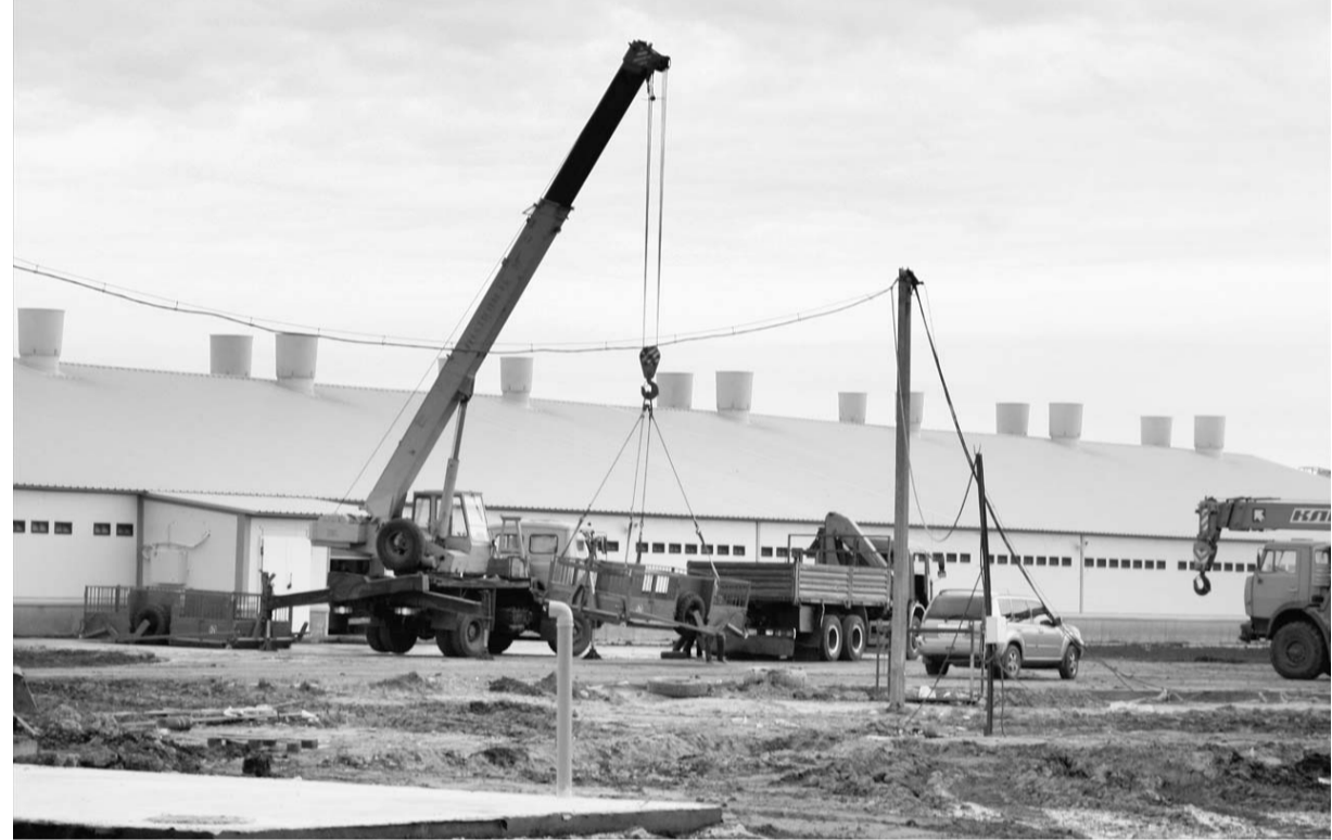
Близится к завершению строительство Одинцовского комплекса.
