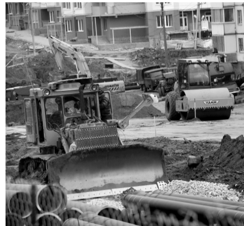
Техника на строительстве дороги работает без простоев
