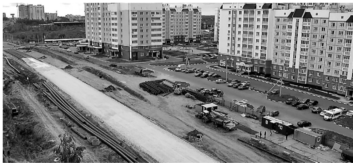
Панорама дорожной стройки с камер видеонаблюдения
