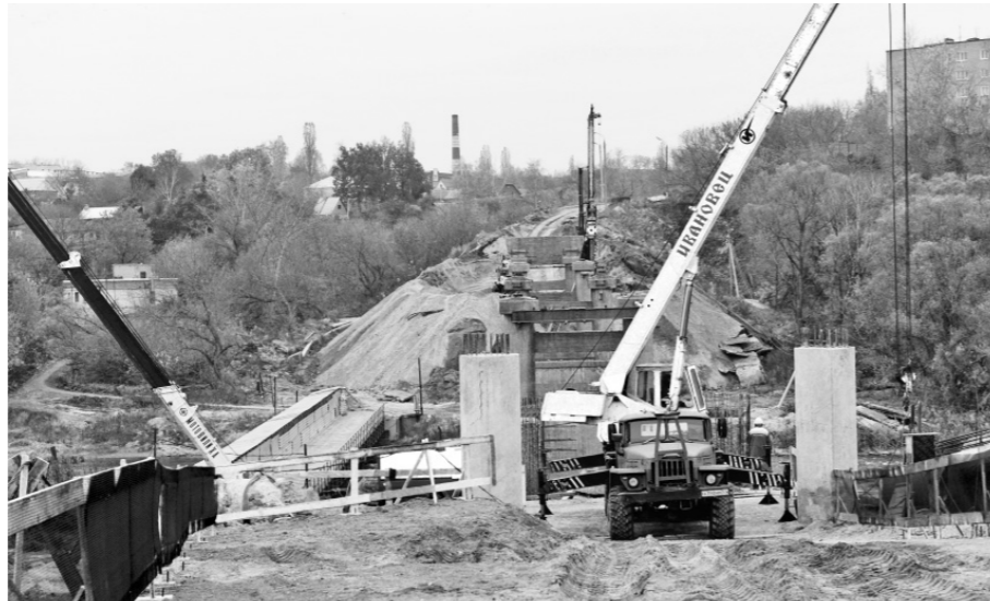
Мост сдадут весной 2017 года
