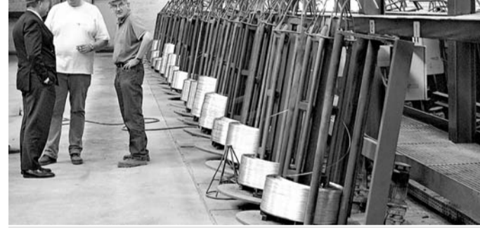
Новая линия по производству оцинкованной проволоки.
