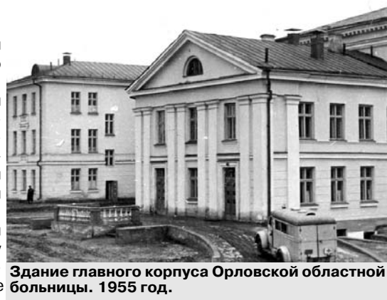
Здание главного корпуса Орловской областной больницы. 1955 год.
