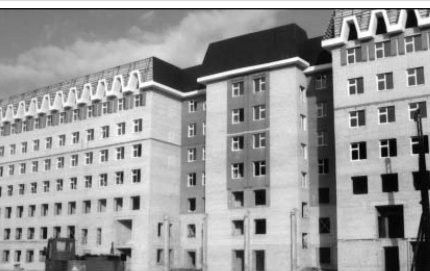
Строящийся хирургический корпус.
