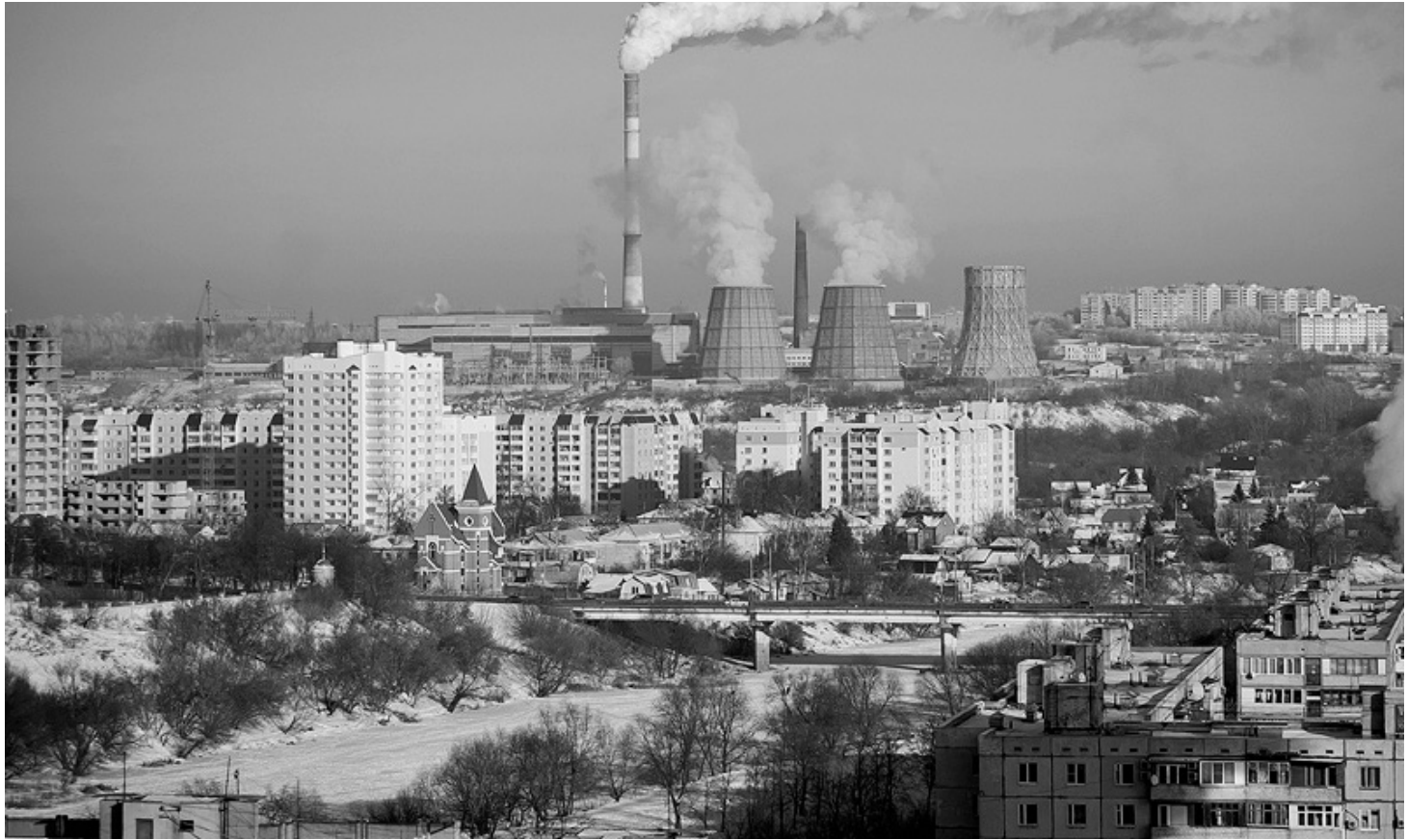
К сожалению, сегодня жалоб на протечки кровли и канализации, неубранные подъезды, мусорные контейнерные площадки больше, чем хотелось бы
