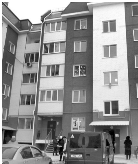
Дом № 46 на улице Луговой был сдан со строительными недоделками
