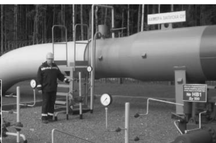
Реконструированный участок газопровода КС «Ногинск» — КС «Воскресенская».
