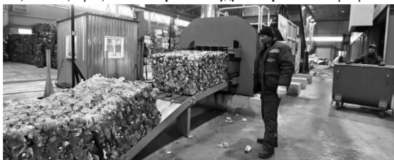
Прессование мусора позволяет сократить транспортные расходы
