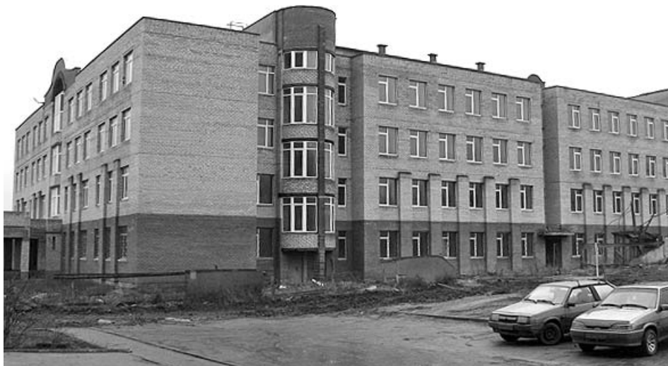
В этом здании недостроенной школы будет создан новый учебный комплекс.
