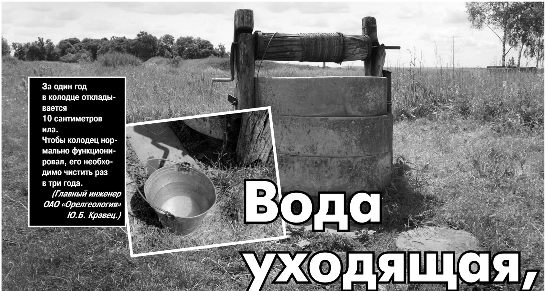
За один год в колодце откладывается 10 сантиметров ила. Чтобы колодец нормально функционировал, его необходимо чистить раз в три года.
