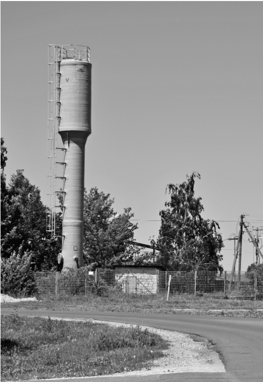
18-метровая водонапорная башня из композитных материалов в Колпне — таких всего три в России
