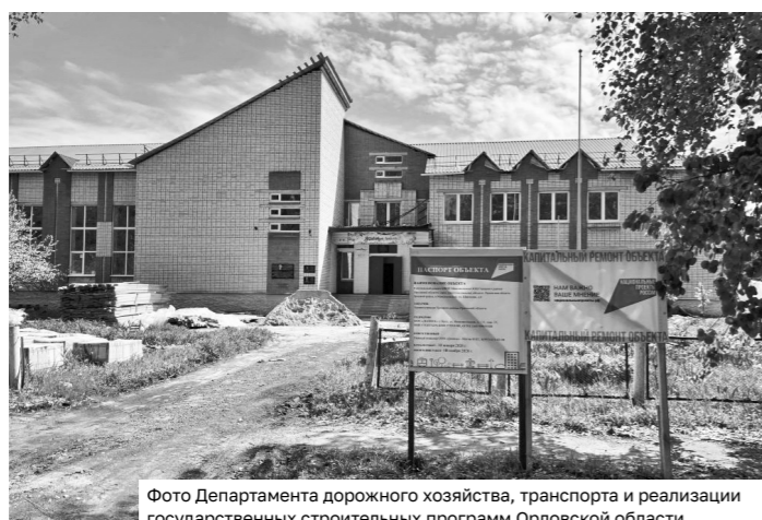
Фото Департамента дорожного хозяйства, транспорта и реализации государственных строительных программ Орловской области
