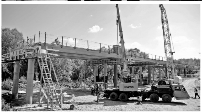
Контуры будущего моста в деревне Тайное
